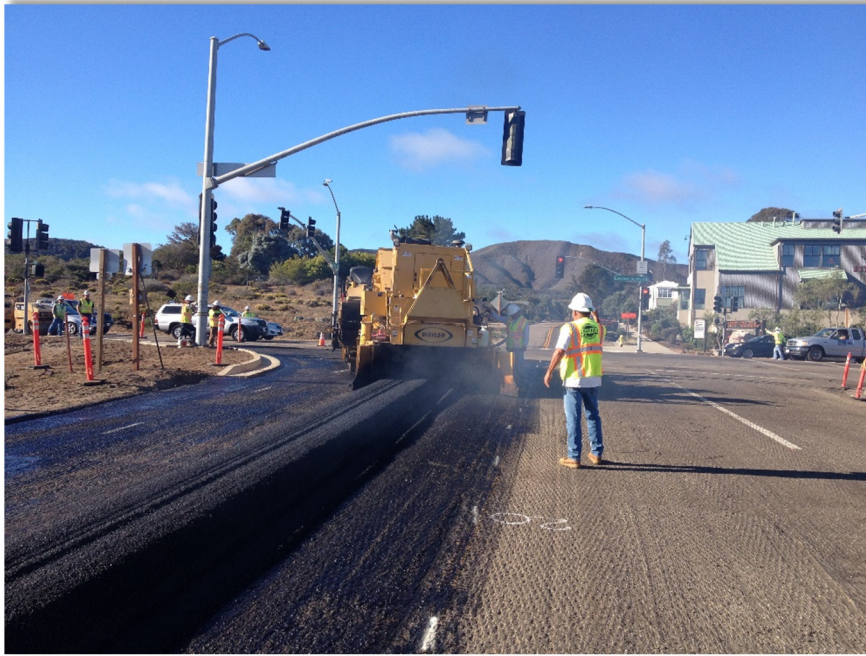
South Bay Overlay, Los Osos
